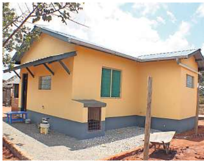
Das fertige Haus.
